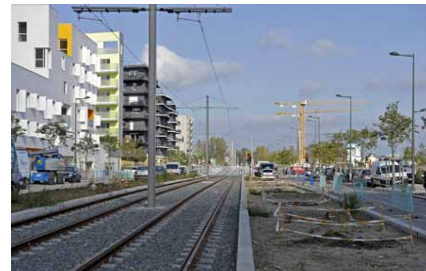
Travaux de la 3 e phase du tramway (photo a'urba)
